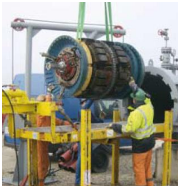
Obrázek 5 Vnitřní inspekce potrubí – vkládání inteligentního ježka
