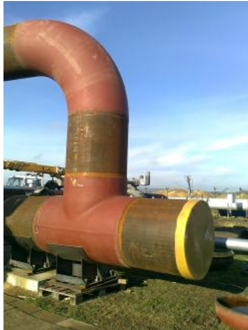
Obrázek 2 Rozdělovací uzel Malešovice – nový propoj DN 1000
