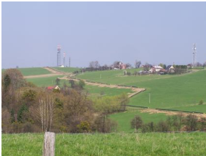
Obrázek 4 Výstavba plynovodu „STORK“
